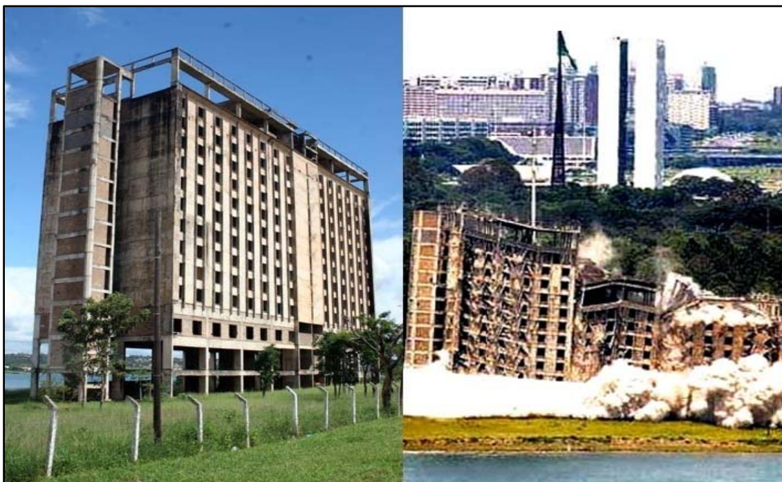
Figura 41 – À esquerda Hotel, abandonado e à direita o mesmo no momento de sua implosão.
